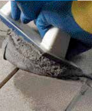
Нанесение Kerapoxu CQ с помощью шпателя MAPEI
